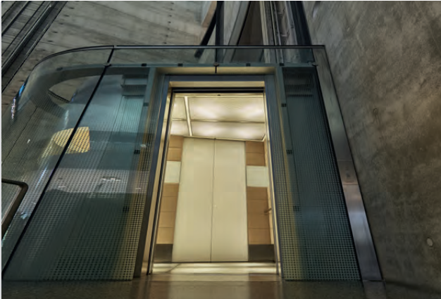
Aufzugsbau Lift fittings
